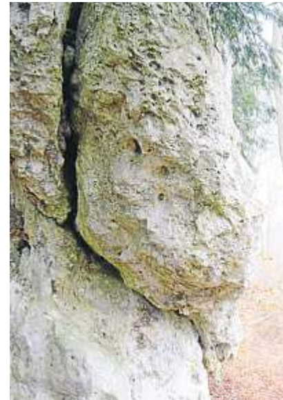
Eine der beiden Gefahrenstellen: „Wie zu erkennen ist, droht hier ein unmittelbarer Felsabsturz“ – der Brocken hängt nur noch an der Wand.
